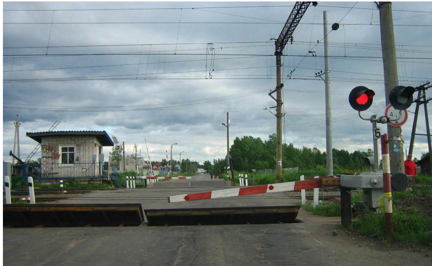
Рис. 4 – Переезд оборудованный УЗП
